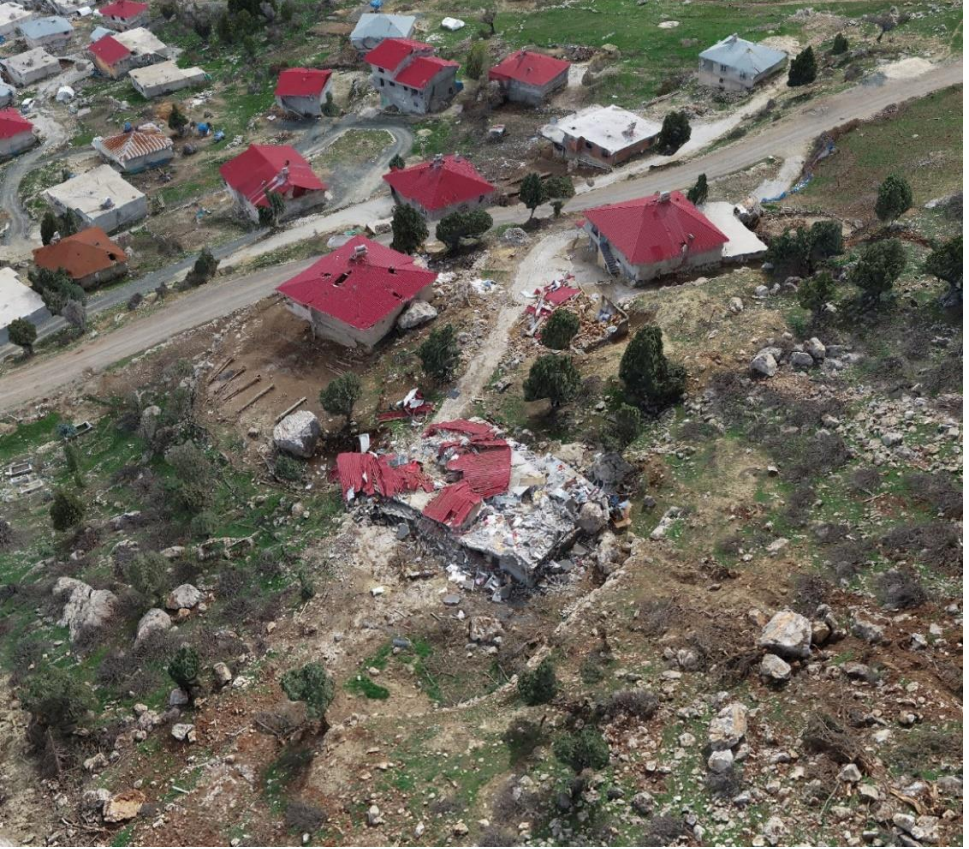
Şekil 22. Kahramanmaraş ili Onikişubat ilçesi Çevrepınar mahallesinde kaya düşmesi sonucu oluşan hasar (AFAD, 2023)
