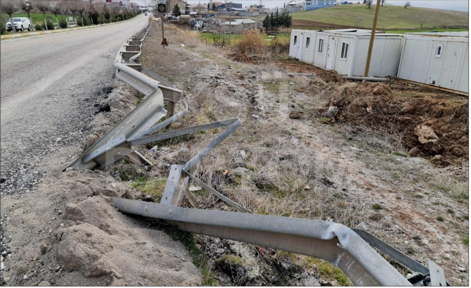
Şekil 14. 06 Şubat 2023 Pazarcık (Kahramanmaraş) depreminde Balkar Beldesi kuzeyinde Pazarcık-Gölbaşı karayolunu ve hemen batısındaki tarlayı keserek yaklaşık 2 m sol yanal atım oluşturan Pazarcık Segmenti'ne ait yüzey kırığının arazi görünümü
