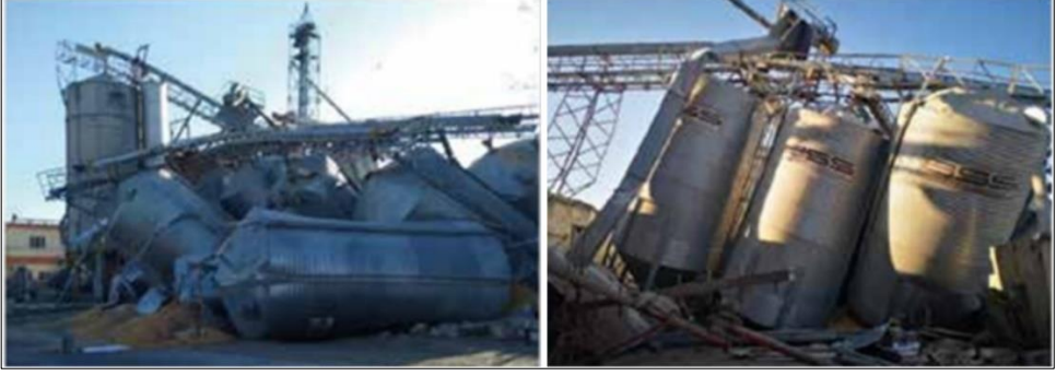
Şekil 3. Gaziantep tahıl deposu (Kahramanmaraş Deprem Raporu, 2023).
