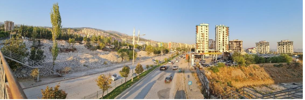
Şekil 5. 6 Şubat 2004 Kahramanmaraş depremleri sırasında kent merkezinin doğusunda zayıf zemin özelliğine sahip alanlarda bulunan tamamı ağır hasarlı binaların görünümü
