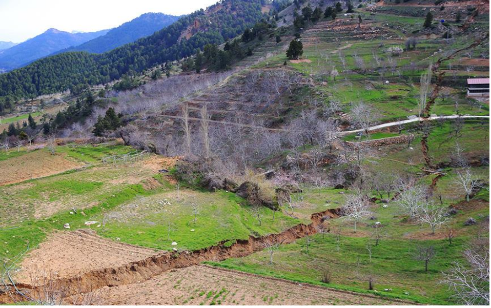
Şekil 1. Kahramanmaraş'ta Meydana Gelen Yüzey Kırığı ve Çökme (Genç ve Akkır, 2023)
