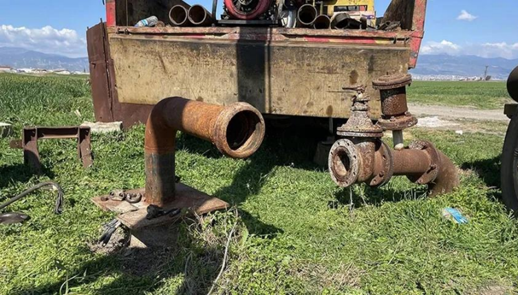
Şekil 7. Depremde Zarar Gören Su Kuyularının Tamir Çalışmaları (Anonim, 2023b)
