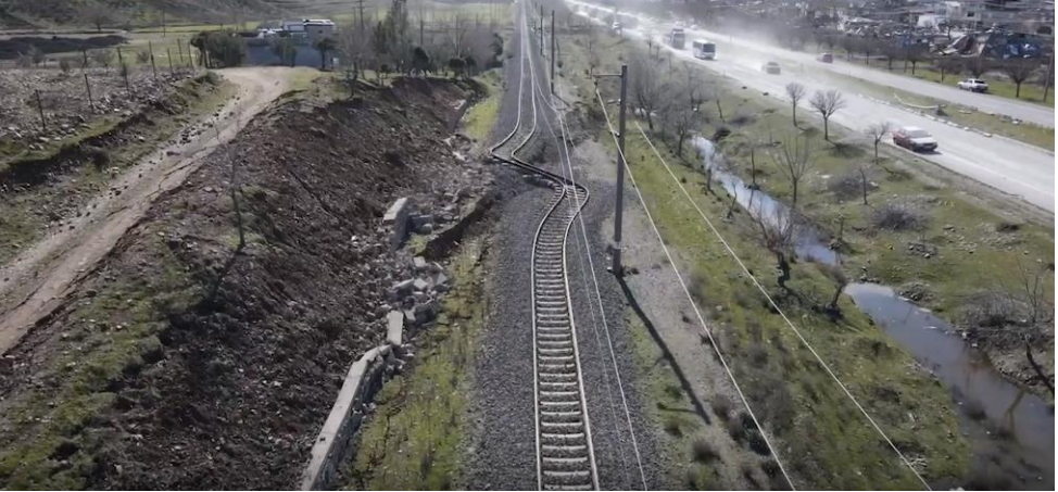
Şekil 12. Depremin Tren Raylarına Etkisi (Anonim, 2023f)
