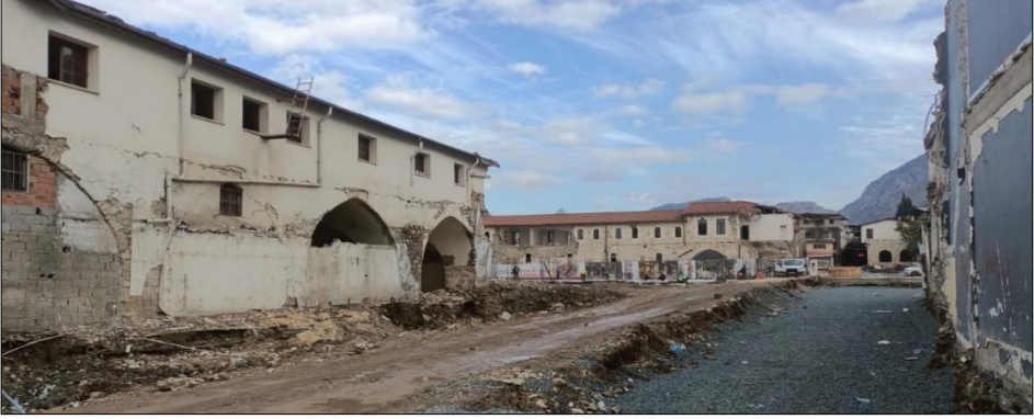
Fotoğraf 4. Antakya Kent Merkezindeki Tarihi Uzun Çarşı İçerisinde Depremden Etkilenen Kültür Varlıkları ve Yeniden İnşa Süreci (10.12.2023)
