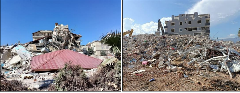
Fotoğraf 2. Antakya Kent Merkezinde Enkaz Olan Binalar (21.03.2023)
