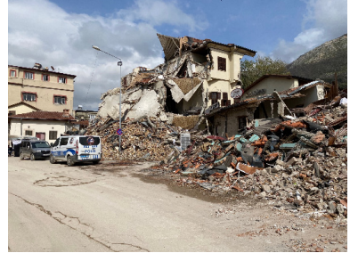
Resim 3. Hatay İli'nde bazı yığma yapı hasarları ve göçen yığma binalar (soldaki resim Habib-i Neccar Camii)
