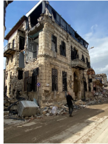
Resim 3. Hatay İli'nde bazı yığma yapı hasarları ve göçen yığma binalar (soldaki resim Habib-i Neccar Camii)
