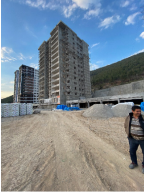
Resim 6. Kahramanmaraş'ta 15 katlı çok sayıda büyük boyutlu perdeler ile perde-çerçeve taşıyıcı sisteme sahip olan 3 blokta, 6 Şubat 2023 Kahramanmaraş Merkezli Depremler sonrasında yapısal ve yapısal olmayan eleman hasarı meydana gelmemesi.
