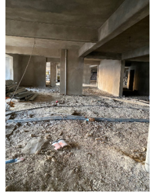
Resim 6. Kahramanmaraş'ta 15 katlı çok sayıda büyük boyutlu perdeler ile perde-çerçeve taşıyıcı sisteme sahip olan 3 blokta, 6 Şubat 2023 Kahramanmaraş Merkezli Depremler sonrasında yapısal ve yapısal olmayan eleman hasarı meydana gelmemesi.
