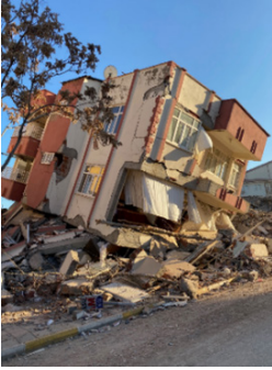
Resim 2. Zemin katında yumuşak kat düzensizliği nedeniyle toptan göçmüş binalar (Adıyaman)
