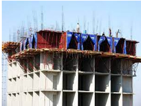
Resim 5. Depremde göçmeyecek bina için bir seçenek; Tünel Kalıp Sistem Binalar
