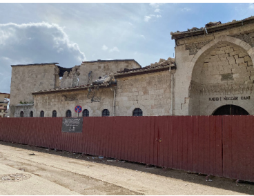
Resim 3. Hatay İli'nde bazı yığma yapı hasarları ve göçen yığma binalar (soldaki resim Habib-i Neccar Camii)
