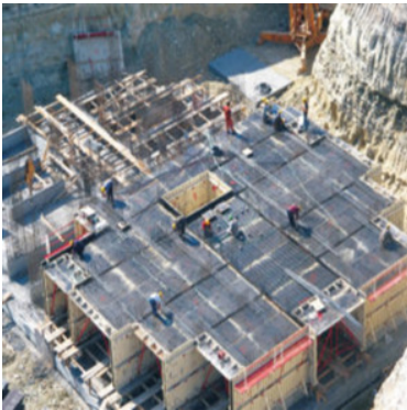
Resim 5. Depremde göçmeyecek bina için bir seçenek; Tünel Kalıp Sistem Binalar
