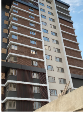
Resim 6. Kahramanmaraş'ta 15 katlı çok sayıda büyük boyutlu perdeler ile perde-çerçeve taşıyıcı sisteme sahip olan 3 blokta, 6 Şubat 2023 Kahramanmaraş Merkezli Depremler sonrasında yapısal ve yapısal olmayan eleman hasarı meydana gelmemesi.
