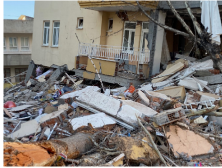
Resim 2. Zemin katında yumuşak kat düzensizliği nedeniyle toptan göçmüş binalar (Adıyaman)
