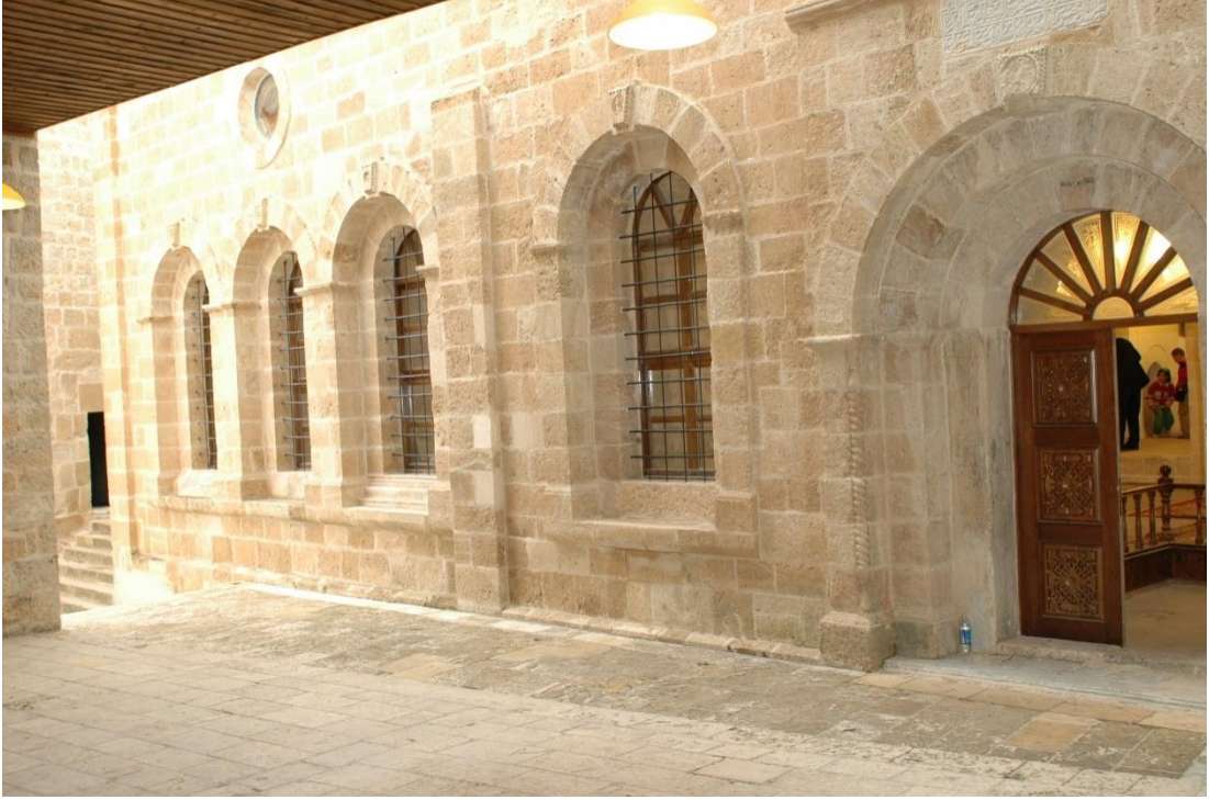
Afşin Eshab-ı Kefh Camii, doğu cephe.
