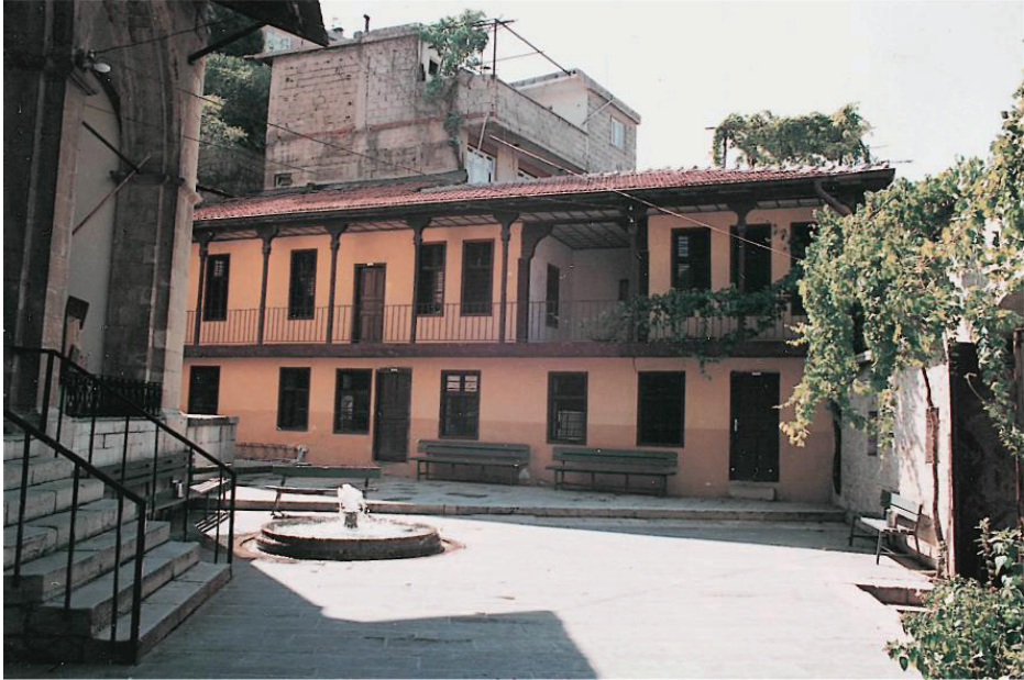
Fotoğraf 6: Kahramanmaraş Acemli (İskender Bey-Şehit Evliya) Medresesi, batı kanat.
