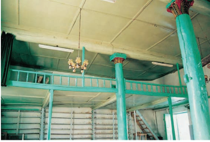
Fotoğraf 24: Afşin – Bakraç (Aristül) Kasabası Eski Camii, iç mekân.
