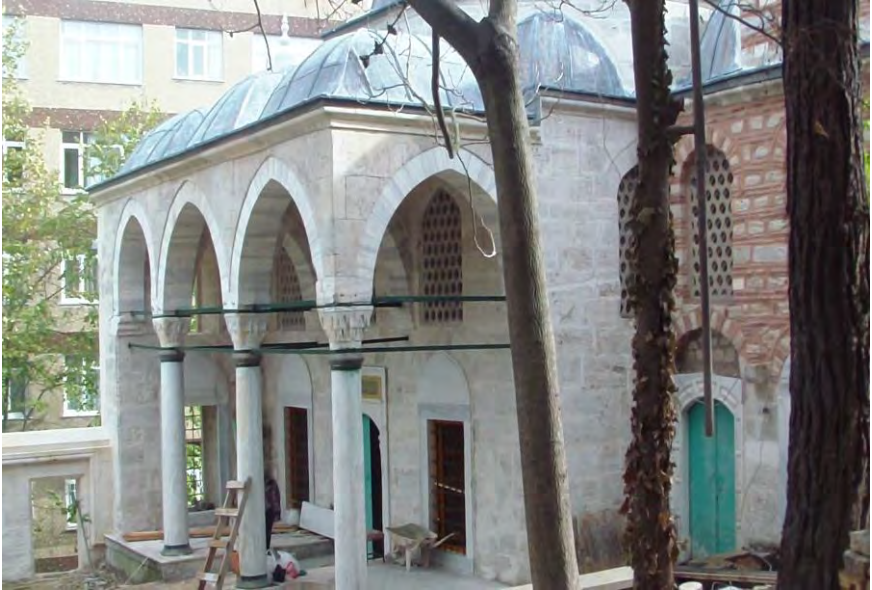
16.Halil Paşa Türbesi-Üsküdar.
