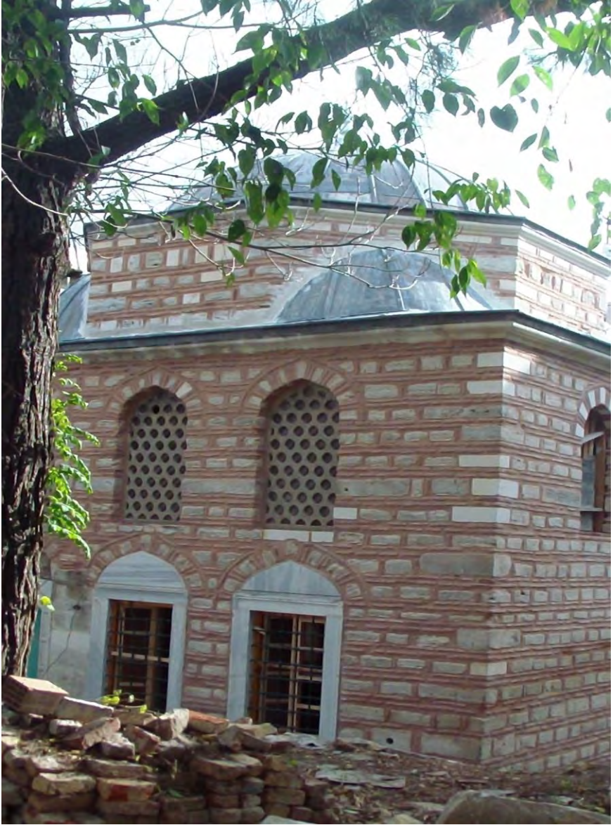
17.Halil Paşa Türbesi- Üsküdar.
