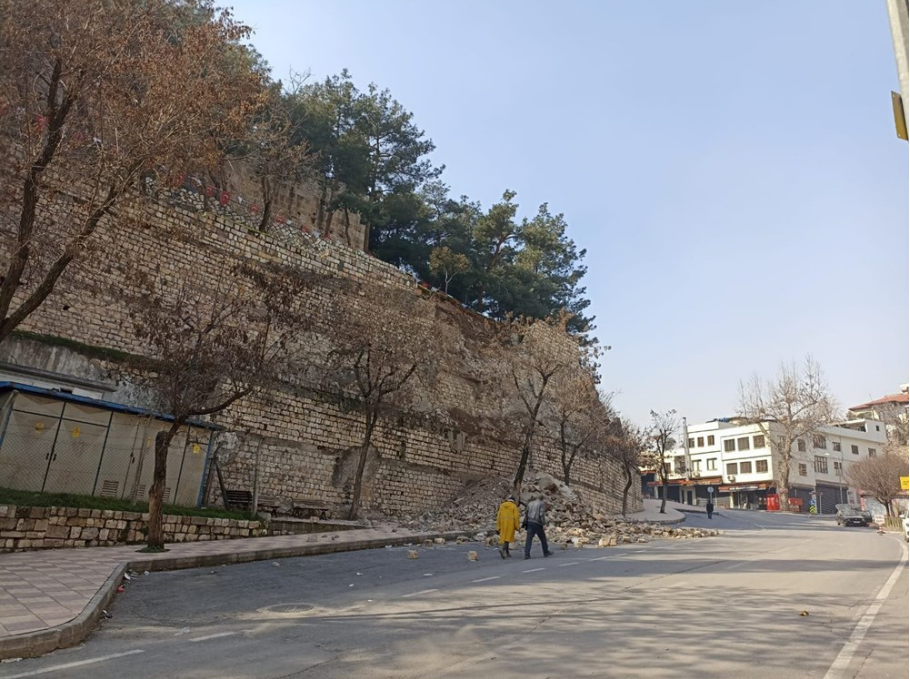
Fotoğraf 3. 6 Şubat depreminde yıkılan kalenin alt kısmında yer alan duvarlardan bir görüntü ( https://www.ntv.com.tr/galeri/turkiye/deprende-tarihi-kahramanmaras-kalesi-de-hasar-gordu,3v2UPhHu8U6tlwazMiy_6Q/X8SiDkVriUaVDwrVSJlc6A Erişim Tarihi: 28.02.2024, Erişim Saati : 00:23).
