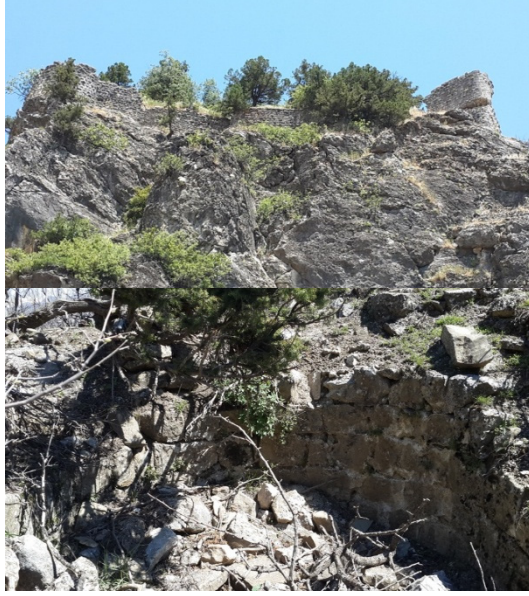
Fig.11-12: Kaleboynu Gözetleme Kulesi ve Sarıncan ? Görünüm.
