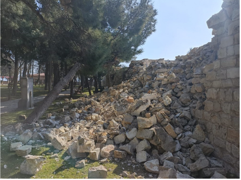
Fotoğraf 4. 6 Şubat depreminde Kale içinde meydana gelen yıkım (https://www.ntv.com.tr/galeri/turkiye/depreminde-tarihi-kahramanmaras-kalesi-de-hasar-gordu,3v2UPhHu8U6tlwazMiy_6Q/X8SiDkVriUaVDwrVSJlc6A Erişim Tarihi: 28.02.2024, Erişim Saati : 00:23).
