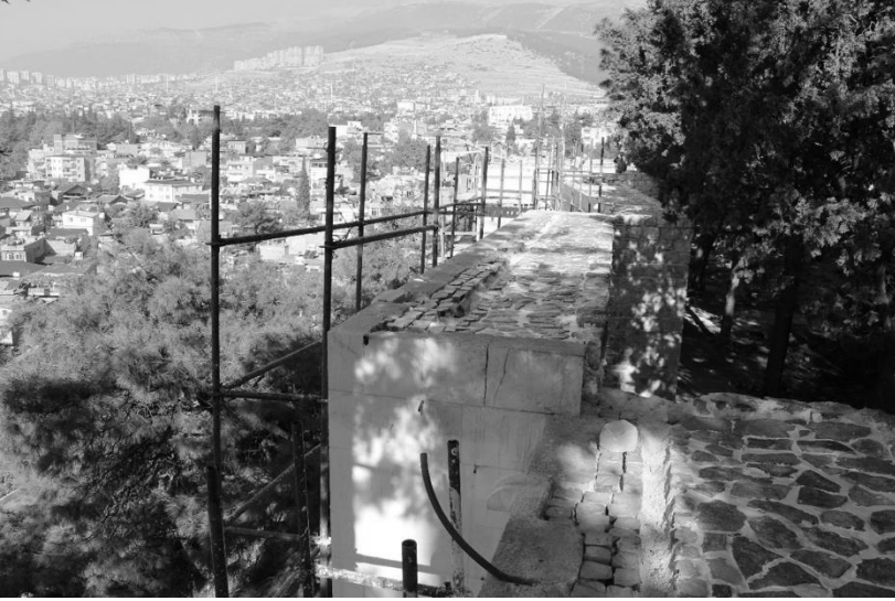
Fotoğraf 10: Kahramanmaraş Kalesi'nin restorasyonu (2017).
